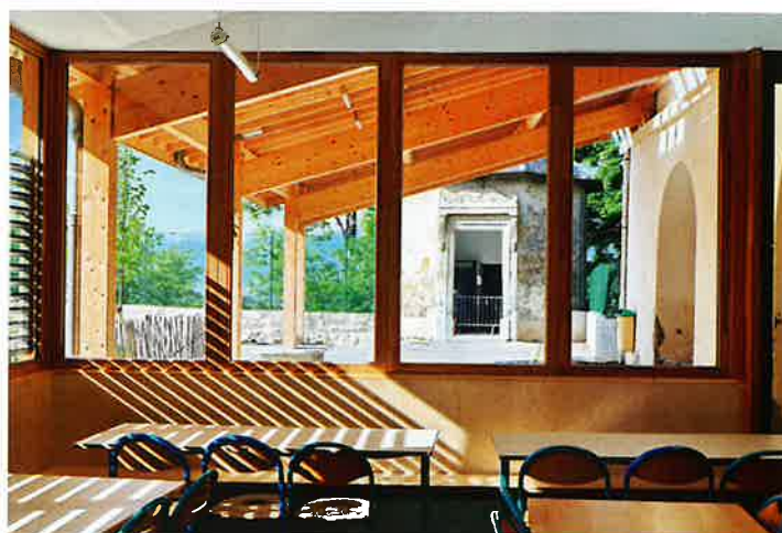
Le récent réaménagement du réfectoire a permis d'optimiser l'isolation thermique, mais également d'améliorer grandement l'acoustique du lieu, qui est fréquenté par près de 1000 élèves par jour. Orienté sud-ouest, il offre un ensoleillement optimal filtré par une charpente en bois.
